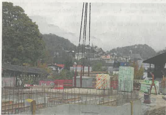
Am Triftsteg entsteht das neue Wohnheim.
