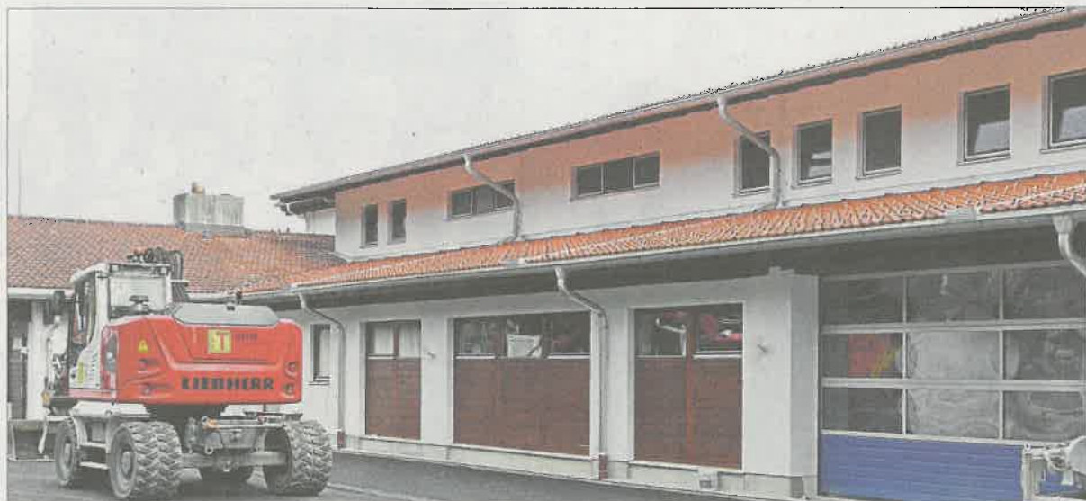
Die Arbeiten am Erweiterungsbau stehen kurz vor dem Abschluss.
