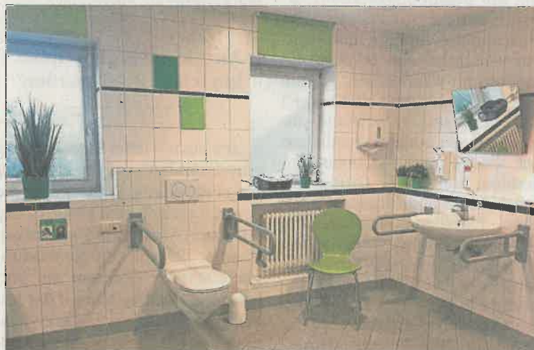
Ein Einblick in eine sanitäre Einrichtung im Wohnhaus Adelstetten der Lebenshilfe Berchtesgadener Land – Foto: Lebenshilfe BGL
